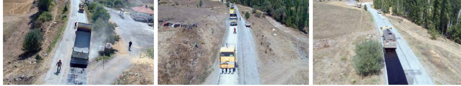
DOKUZ KÖYÜ II.KAT ASFALT KAPLAMA ÇALIŞMALARI
