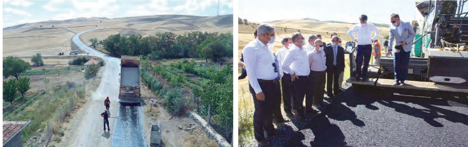
ASFALT YOL ÇALIŞMASI
