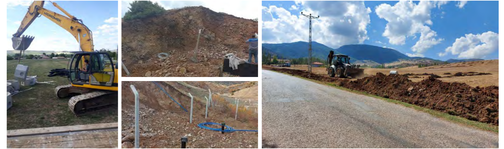
KAZANKAYA, DEREÇİFTLİK VE KÖSRELİK KANALİZASYON ÇALIŞMALARI
