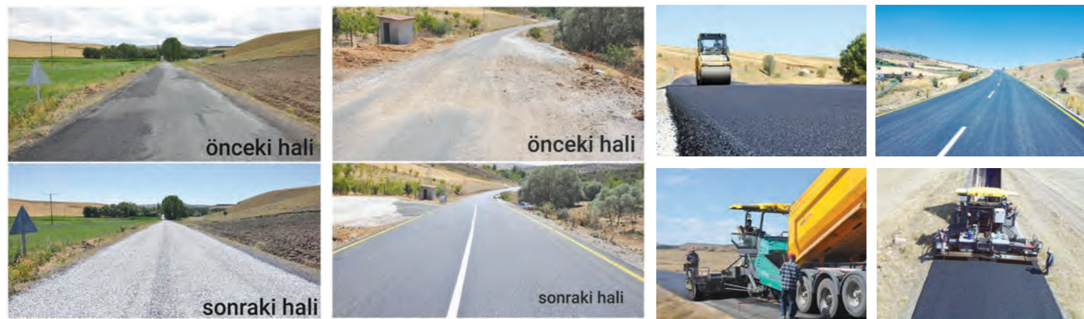
2. KAT YOL YAPIM İŞİ
