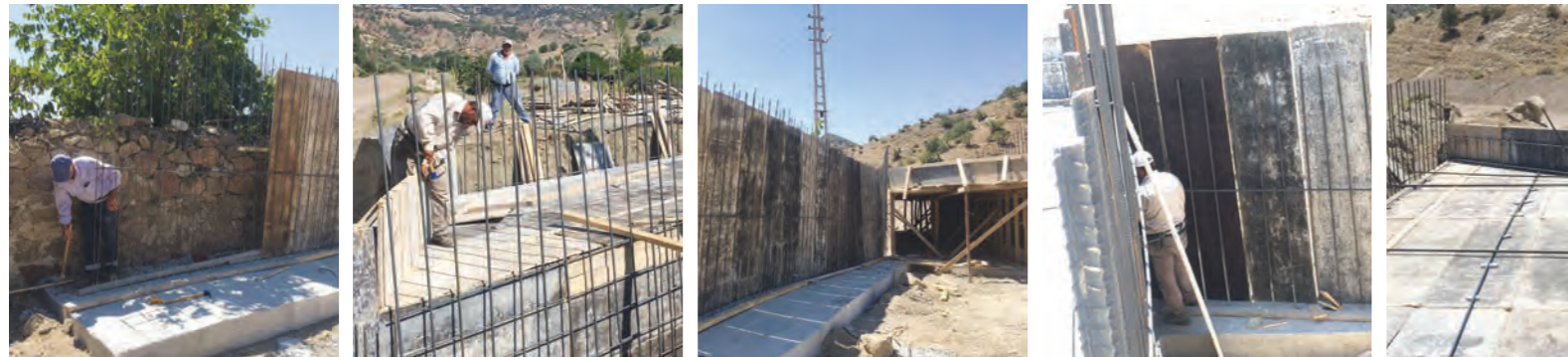
HACIİLYAS KÖYÜ İÇME SUYU DEPOSU VE KÖRÜ ÇALIŞMALARI
