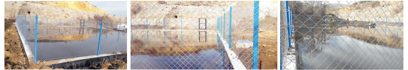
ÇALATLI KÖYÜ SULAMA ÇALIŞMALARI
