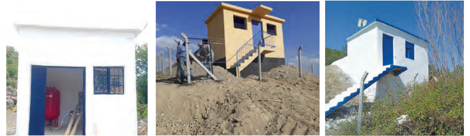
BOYALIK, EYNELLİ KÖYÜ İÇME SUYU DEPOSU ÇALIŞMALARI
