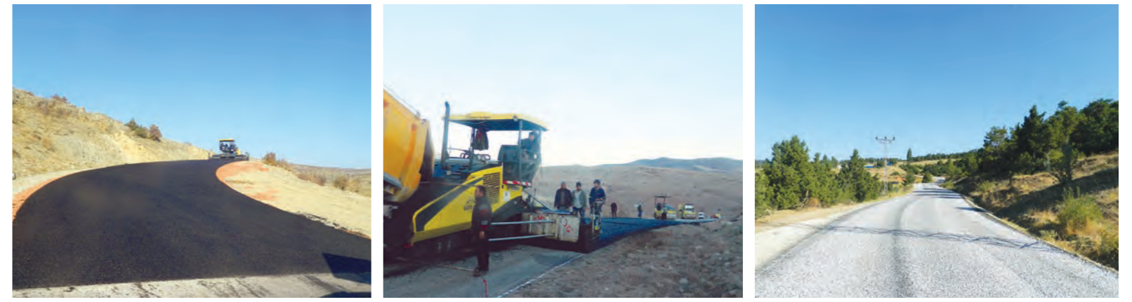
BSK YOL VE ASFALT MICİR YOL ÇALIŞMALARI
