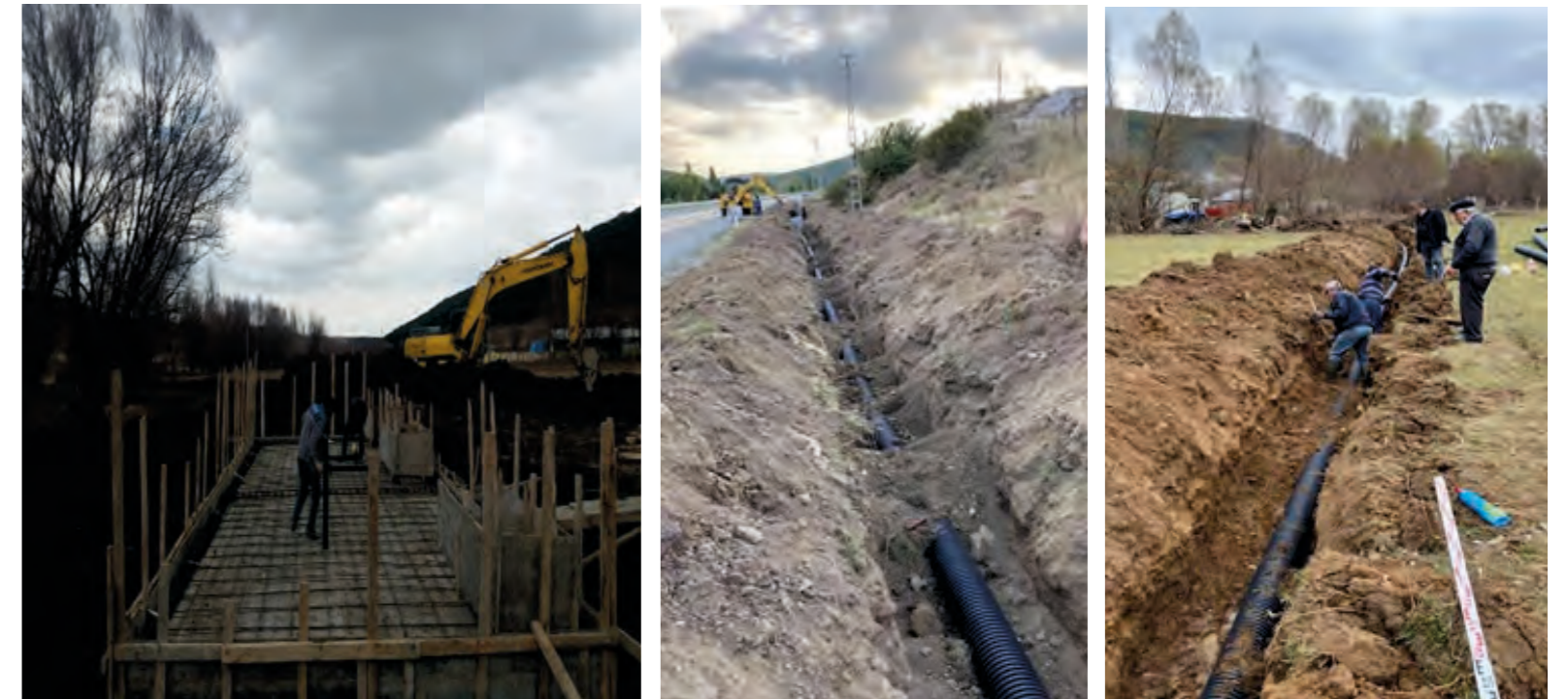
BOZHÖYÜK KÖYÜ KANALİZASYON ÇALIŞMALARI
