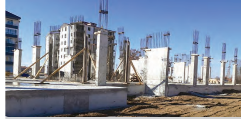
BOĞAZLIYAN GAZİPAŞA ORTAOKULU
