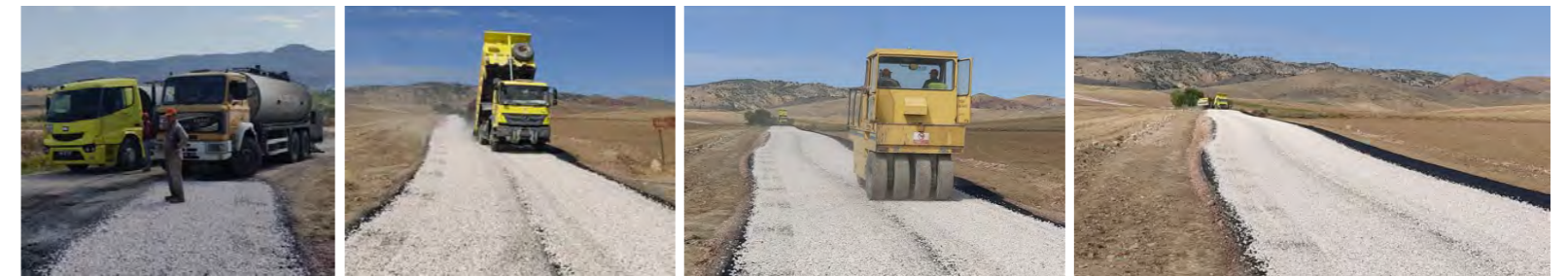
KÜÇÜKTORAMAN KÖYÜ I. KAT ASFALT ÇALIŞMALARI
