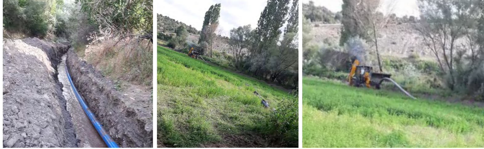
HAVUZDAN SULAMA TESİSİ ÇALIŞMALARI
