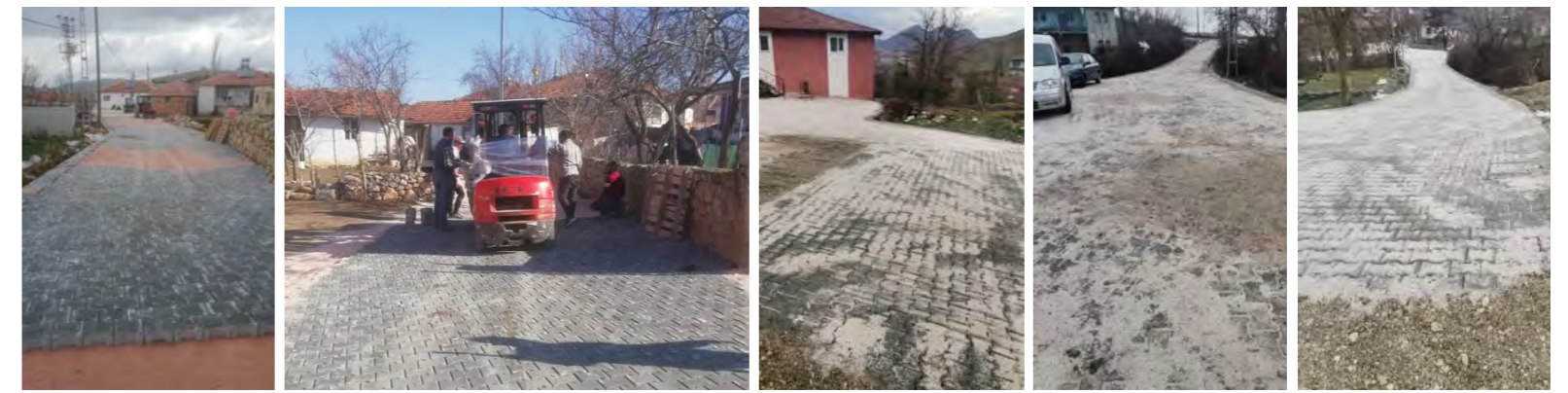
AŞAĞIKUYUCAK, KUYU KÖYÜ KİLİT PARKE ÇALIŞMALARI
